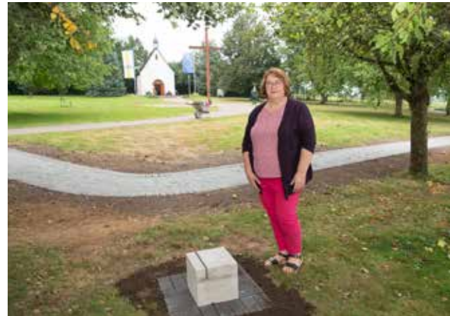
Bernadette Ahle vor dem Kreuzweg – die Stelen werden noch auf den Betonfundamenten installiert Foto: Karl-Martin Flüter
